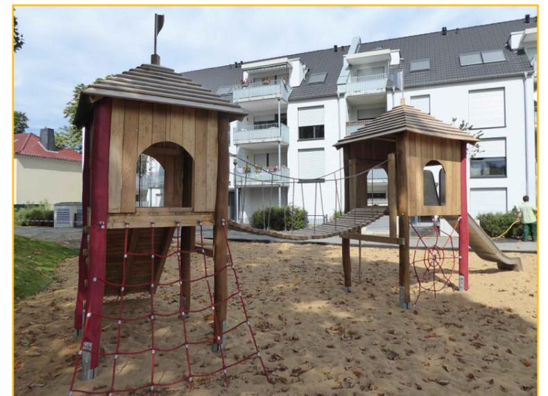
Maximale freie Fallhöhe des Gerätes: 1,50m
