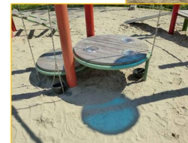
Maximale freie Fallhöhe des Gerätes: 0,60m
