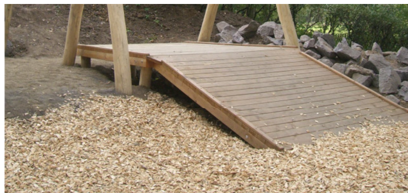
Rampe f. Seilbahn
