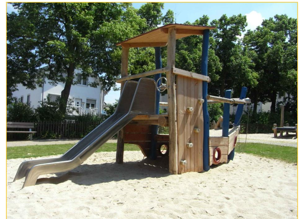
Maximale freie Fallhöhe des Gerätes: 1,95m
